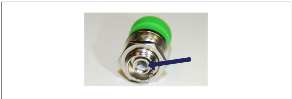
図3.29 破損したコネクタ
